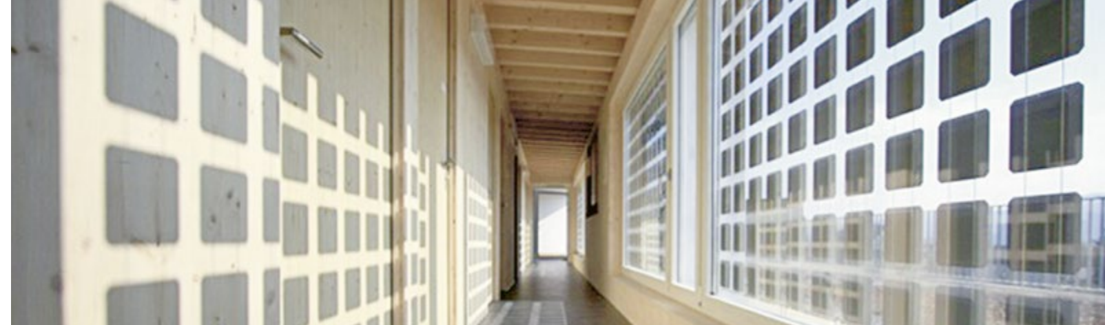
Bild: Fassaden PV-Module für die Minergie-P-Modernisierung eines Mehrfamilienhauses in Wettingen | © Miloni Solar AG, Wettingen
