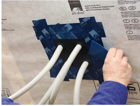
Illustration 10 : Manchette appropriée pour gaines multiples (source : image gauche : pro clima Suisse GmbH, image droite : Kel-DPU)
