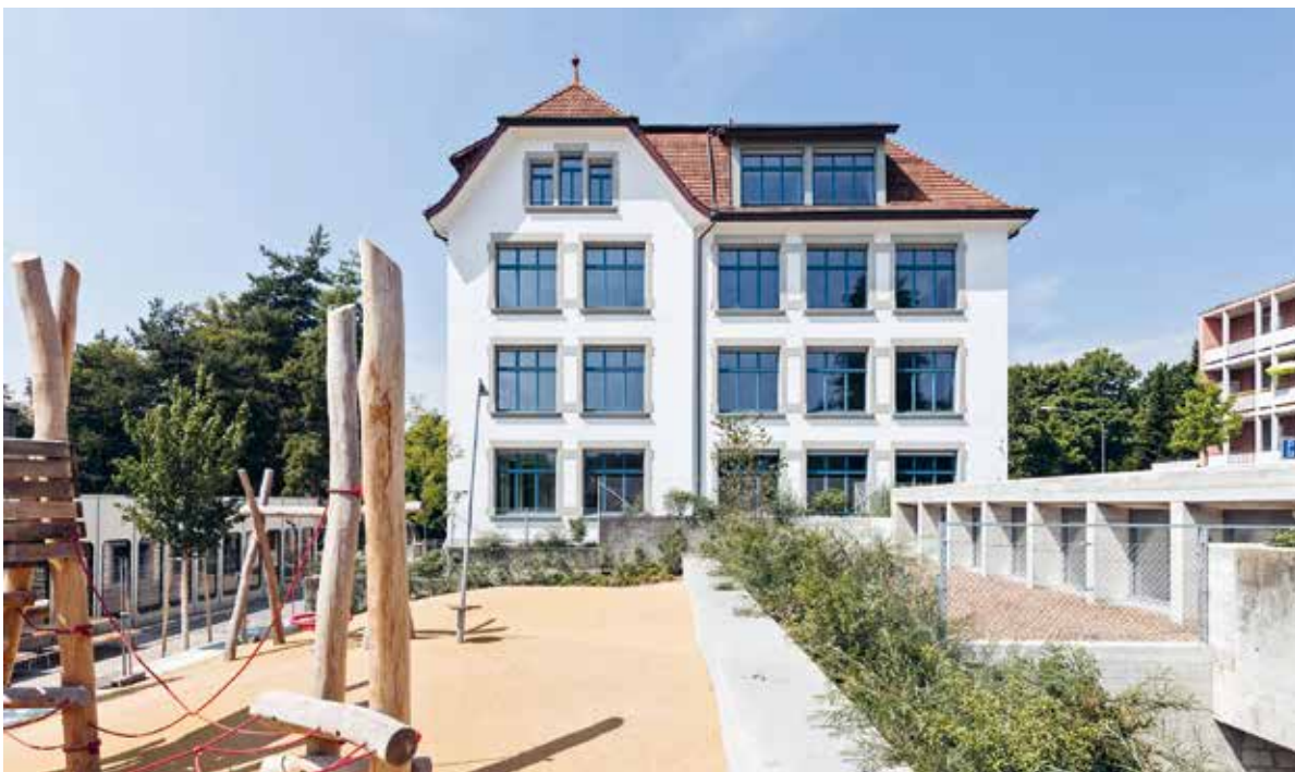
Vue extérieure du bâtiment scolaire Bläsi rénové à Zurich-Höngg.
