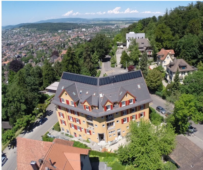
Abbildung 39: Bei der Renovation des Studentenheims Justinus-Haus in Zürich wurden 70.5 m 2 unverglaste Absorber auf dem Dach installiert, mit denen die 6 je 380 m langen Erdsonden regeneriert werden können. Bild © kämpfen zinke+partner
